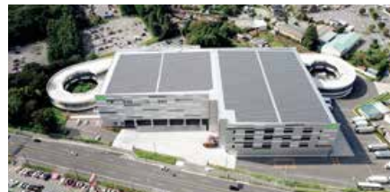
物流センターの屋上に設置された太陽光パネル (野田船形物流センター)
